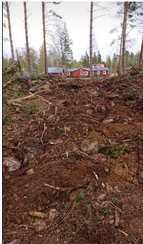
En del av slingan där markarbetena är i ett tidigt skede..
